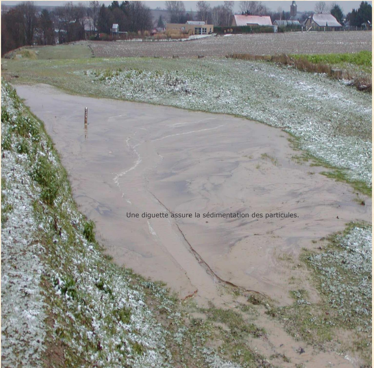
Une diguette assure la sédimentation des particules.
