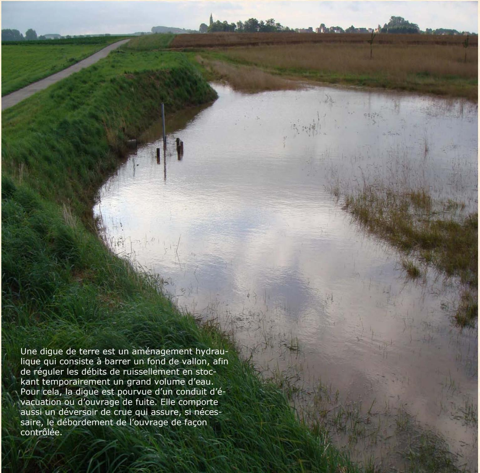
Une digue de terre est un aménagement hydraulique qui consiste à barrer un fond de vallon, afin de réguler les débits de ruissellement en stockant temporairement un grand volume d'eau. Pour cela, la digue est pourvue d'un conduit d'évacuation ou d'ouvrage de fuite. Elle comporte aussi un déversoir de crue qui assure, si nécessaire, le débordement de l'ouvrage de façon contrôlée.
