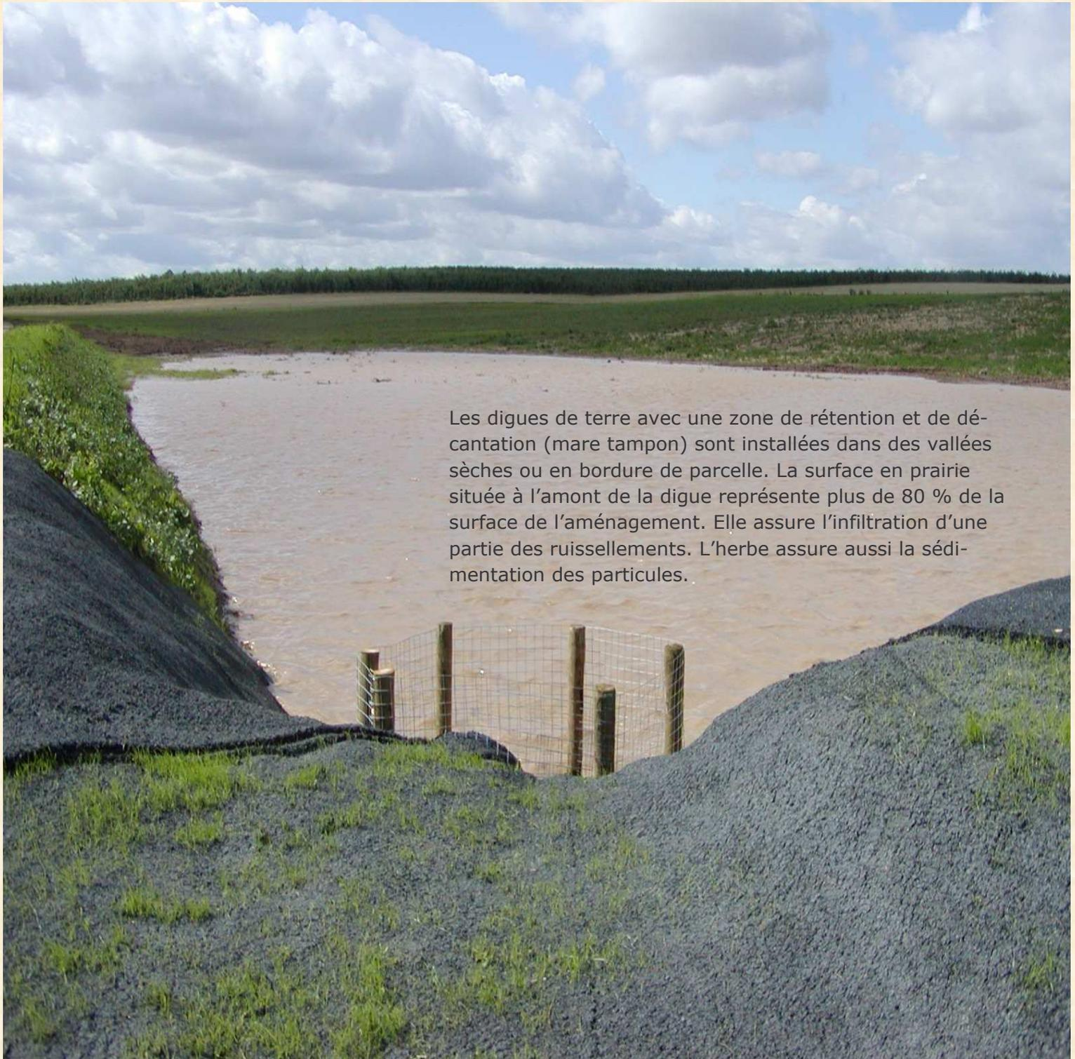
Les digues de terre avec une zone de rétention et de décantation (mare tampon) sont installées dans des vallées sèches ou en bordure de parcelle. La surface en prairie située à l'amont de la digue représente plus de 80 % de la surface de l'aménagement. Elle assure l'infiltration d'une partie des ruissellements. L'herbe assure aussi la sédimentation des particules.
